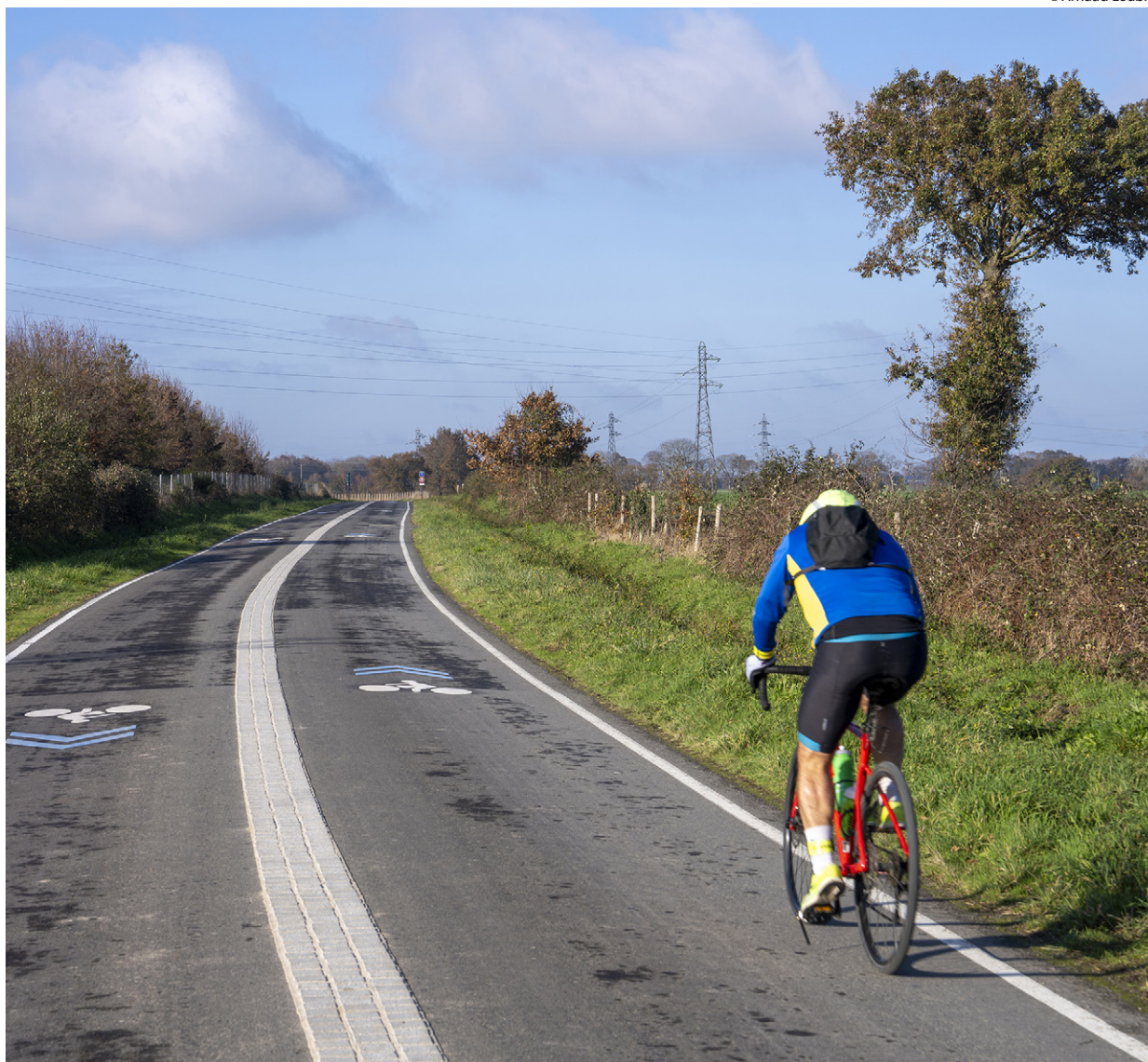
↑ La nouvelle liaison vélo Rennes-Pacé, un parcours sécurisé de 5,5 km.
