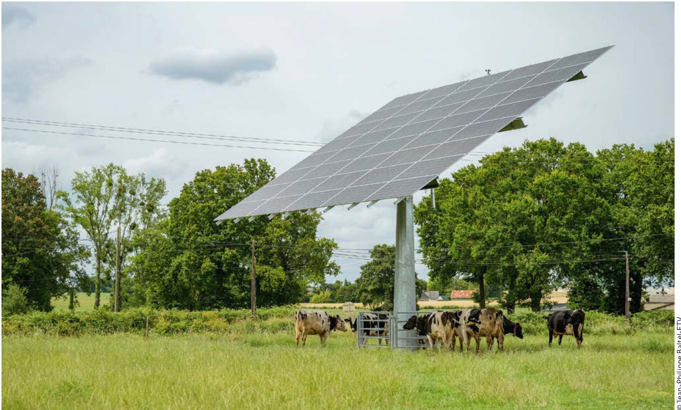
Le tracker solaire (panneau qui suit les mouvements du soleil) vient d'une société d'Ille-et-Vilaine.
